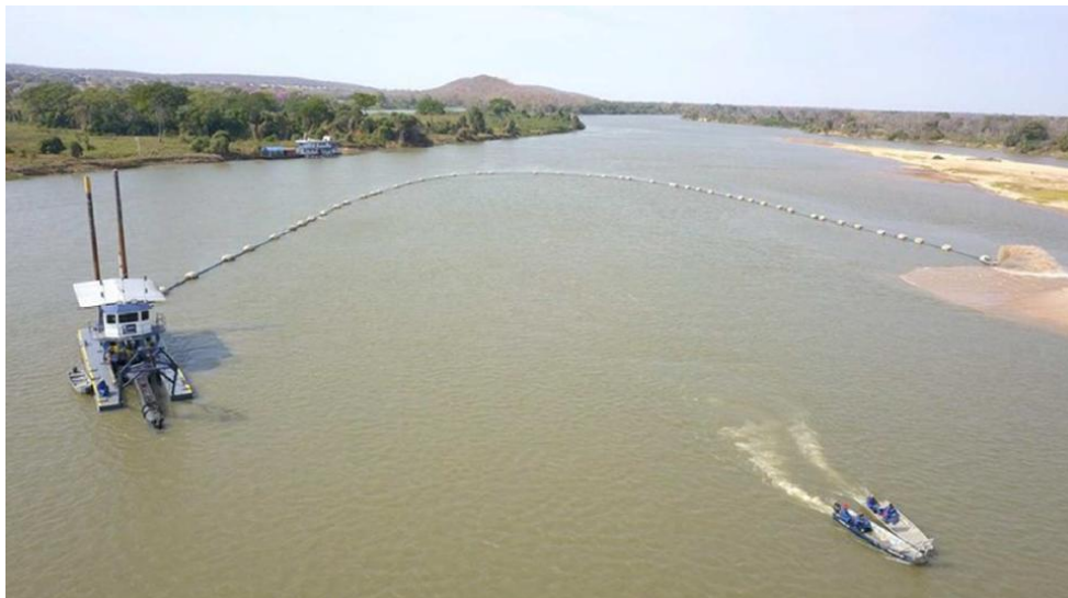
Figura 4: Dragagem no Rio Paraguai no Tramo Norte (INFRA et al., 2025b).
